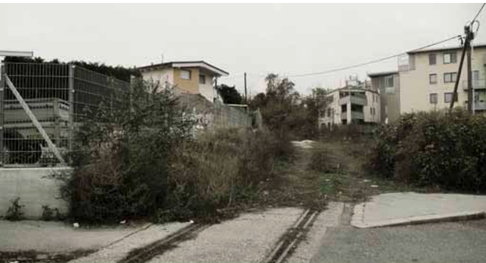
QUELLENSTRASSE EHEMALIGES BAHNTRASSE
