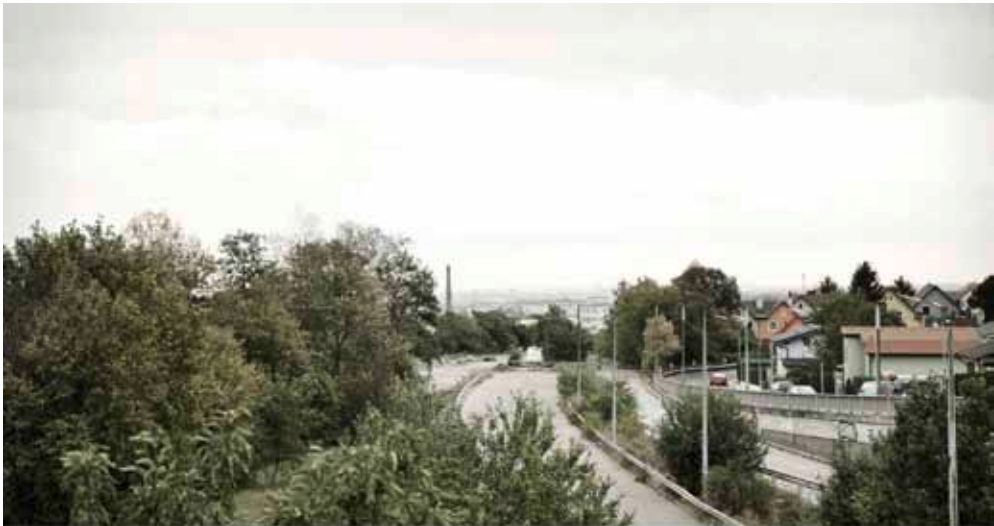
BRÜCKE AUSLAUFENDE AUTOBAHNZUFAHRTEN
