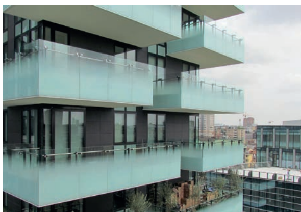
C25.2 EXTERIOR SOLARIA
