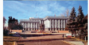
Abb 7 Vorher-Nacher des Mazedonischen Regierungsgebäudes
